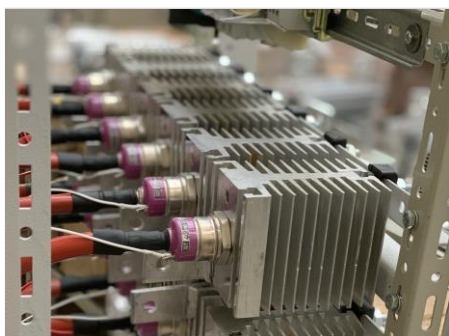
с естественным воздушным охлаждением тиристоров от 6А до 1000А
